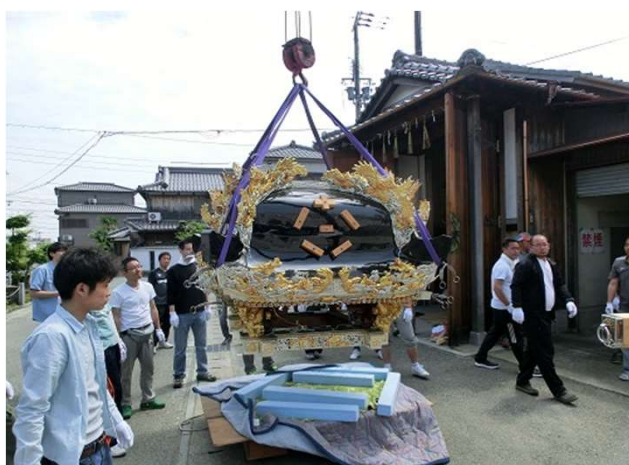
屋根を吊り上げます。
